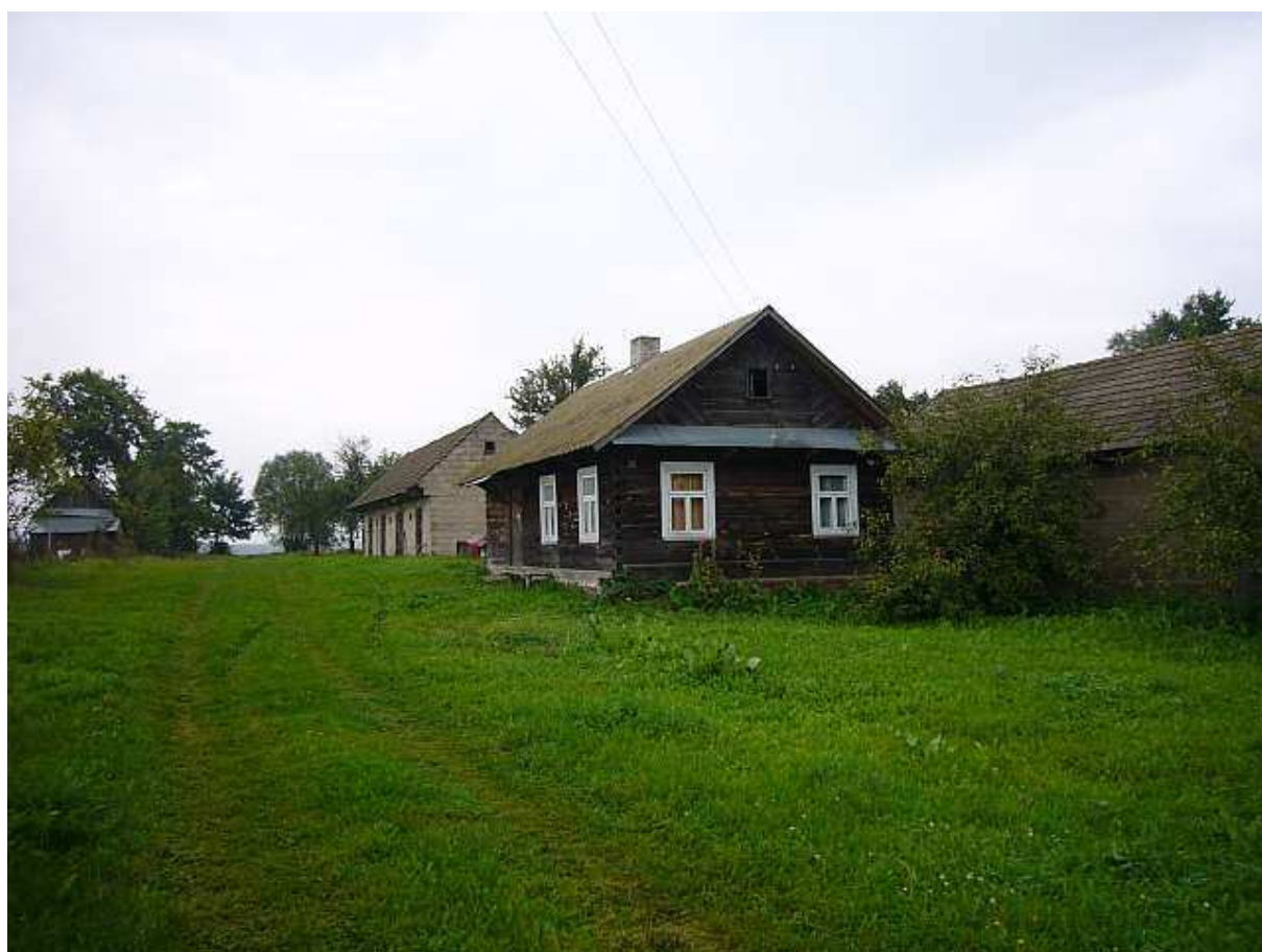
Fot.1. Wieś Ploski – zabytkowy budynek nr 94
