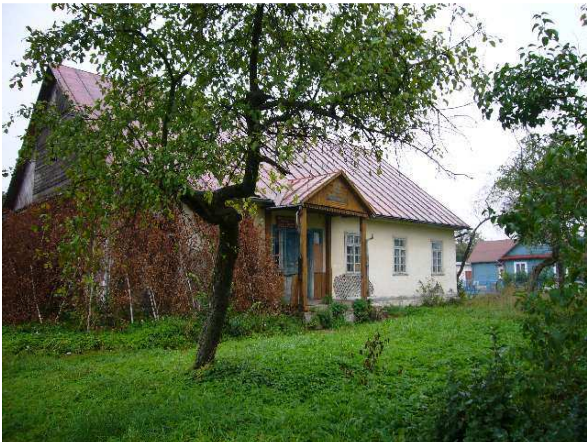
Fot.3. Wieś Ploski – zabytkowy budynek szkoły
