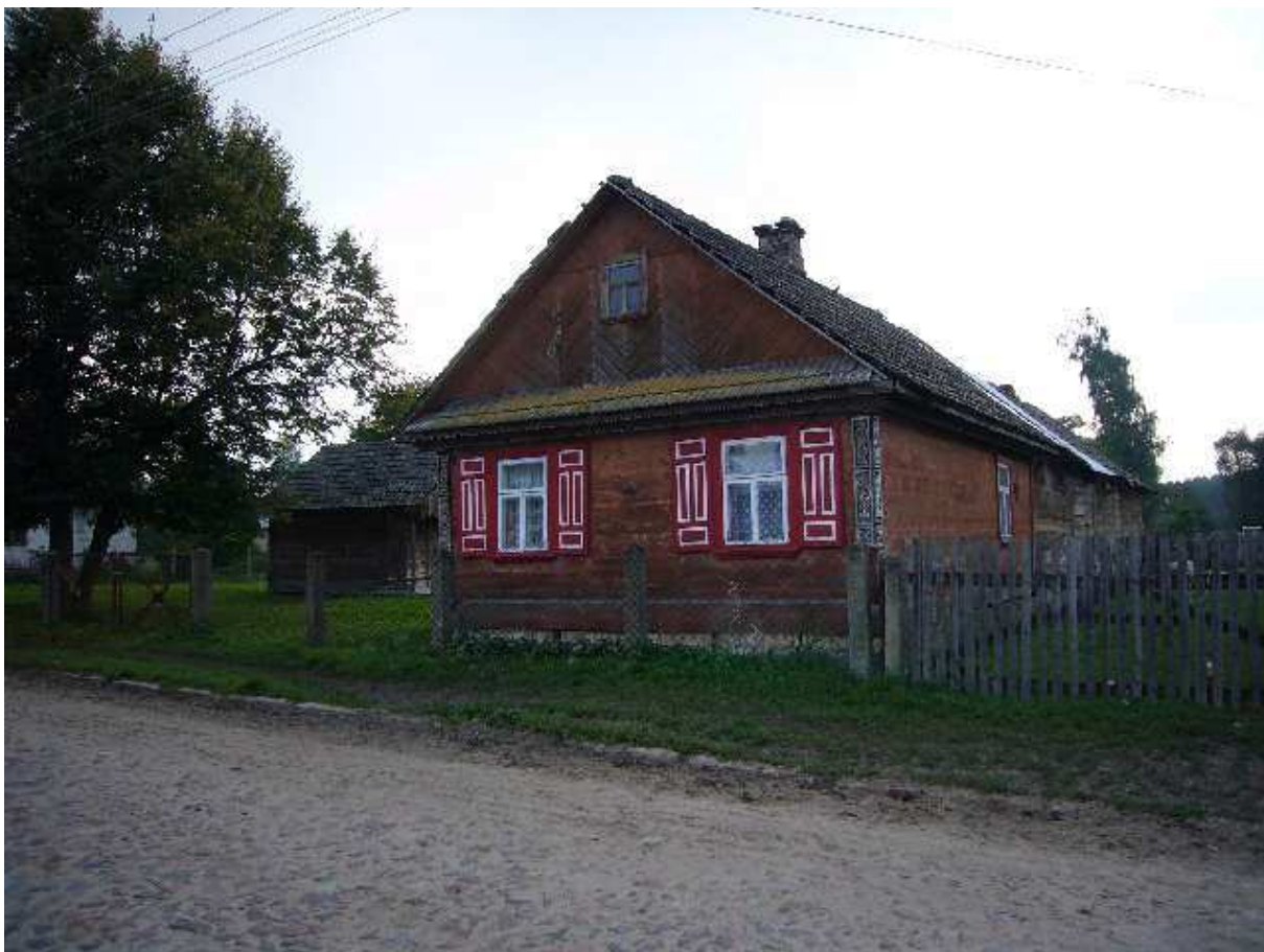
Fot.52. Wieś Husaki, budynek nr 49
