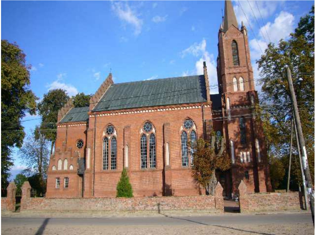
Fot.66. Wieś Łubin – kościół, obiekt wpisany do rejestru WKZ
